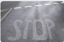
Fresado sobre asfalto
